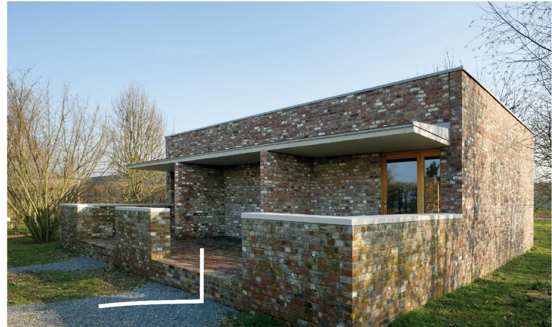
met muurtjes vast aan maaiveld
