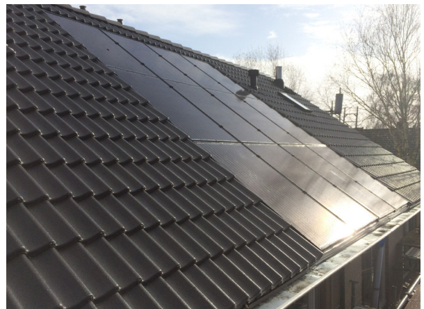
geïntegreerde zonnepanelen
